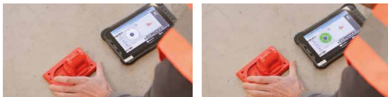
Verschieben der Absteckhilfe auf der Bodenplatte, bis die Zielposition erreicht wird – sichtbar am grünen Kreis.
