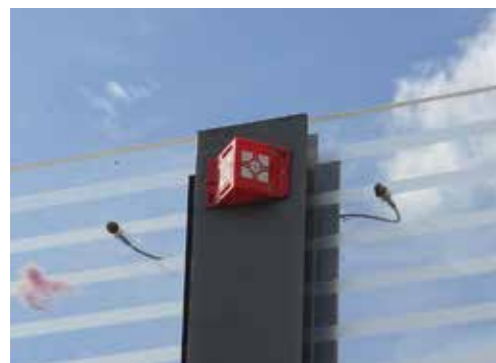
Beobachtungen von Lärmschutzwänden
