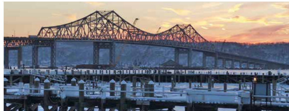
Brückenbeobachtung (Tappan Zee Bridge USA)
