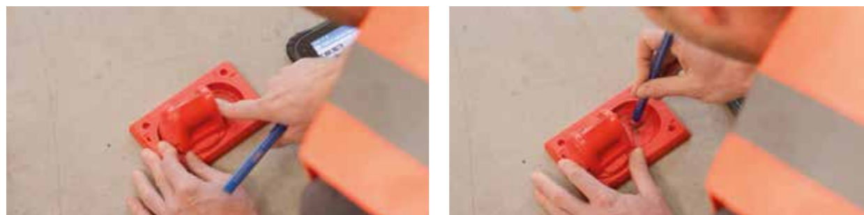
Prisma zur Seite schieben und die Zielposition mit einem Stift markieren.
