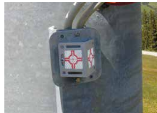
Messpunkt an Skiliftstütze
